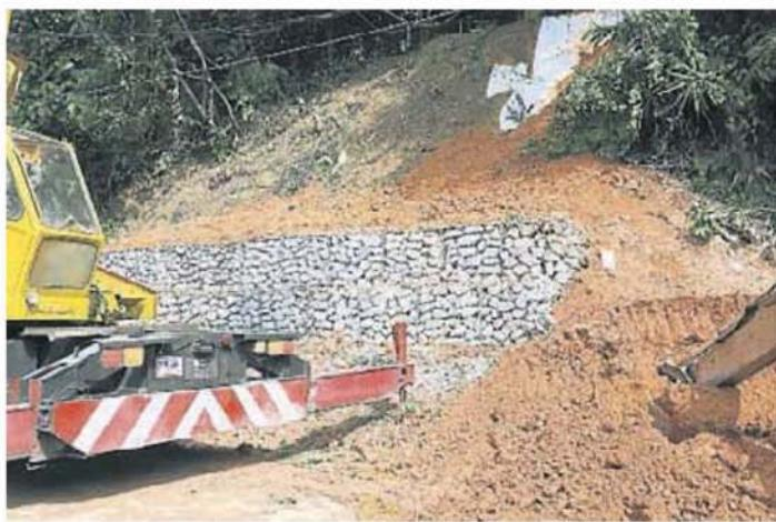
■甲洞乌鲁新村内的山坡获得士拉央市议会批准，进行建筑石墙工作，防止土崩。
