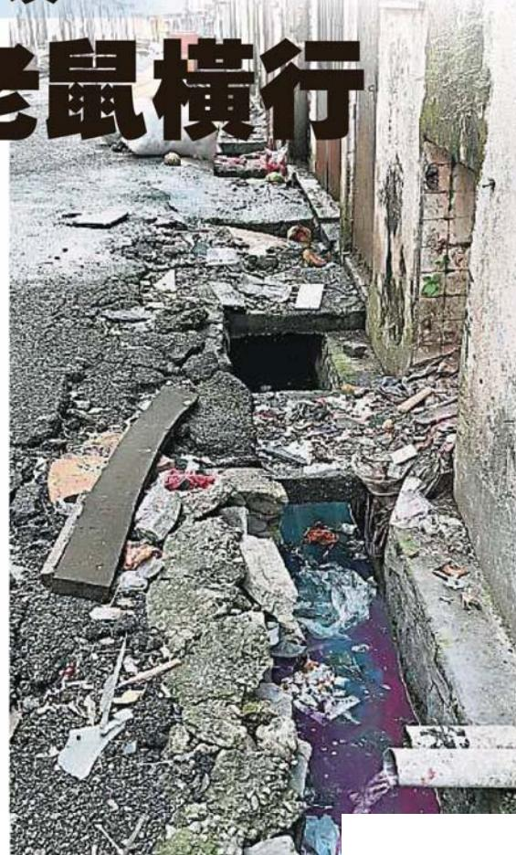
↑ 后巷沟渠崩塌，污水无法排走，又加上垃圾堆积，环境恶劣。
